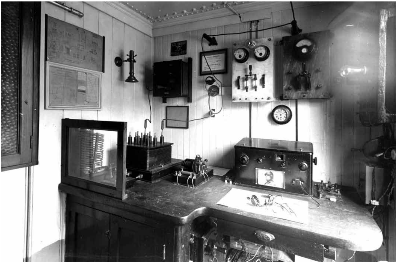
S/s Bengasi (c/s IAW poi IBJE dal 1928). Stazione RT Marconi ital. a scintilla rotante. ½ kW, tipo SRT anni '10. Sul tavolo da sx: induttanza circuito LC; secondario Jigger; vibratore Marconi tipo 144 Tx soccorso; ricevitore (Rx) onde medie (OM) "Marconi tipo 194". Sopra: indutt. d'aereo; quadri comando. Sotto: starter Tx a disco rotante. (foto anni '20).
