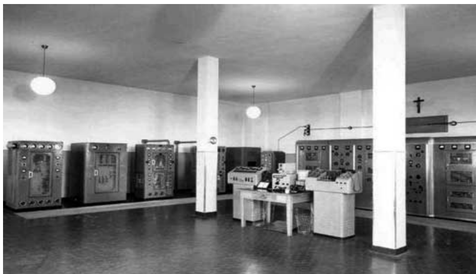
ICB Genova Radio primi anni 1950 Trasmettitori Marconi Classe "Pechino" revisionati ed aggiornati per standard di sicurezza, forse ex Coltano Radio IAC (Trasmettitori 1 e 3 da sinistra)
